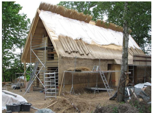
Stråtaget under udførelse
