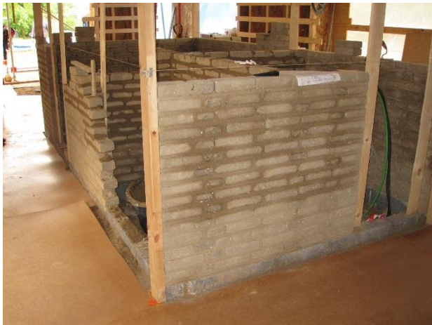
Vådtrum og teknikrum er muret op i lersten midt i bygningen
