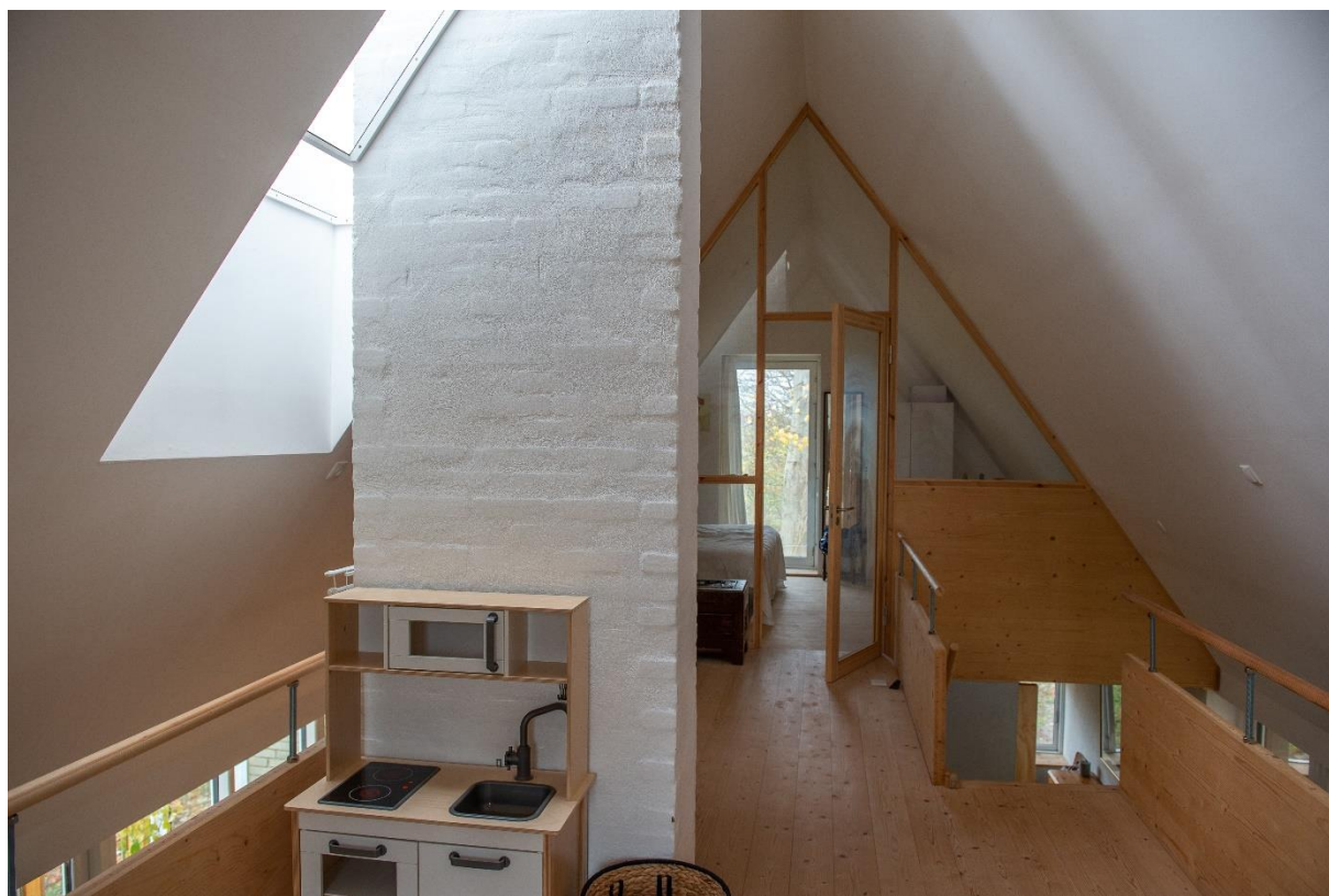
Et kig på 1. sal i Det Åndbare Hus, hvor lys fra solskorstenen kommer ned midt på reposede mellem de to gavlværelser
